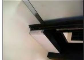
**Punkt 10.** Kleben Sie zweite Isolation auf der Wand mit ein Loch für Schornstein, zusätzlich benutzen Sie Dübel  $\Phi$  8mm.
