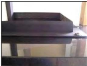
**Punkt 6.** Kleben Sie untere Teil von Isolation bis Wand und festigen Sie alles mit Dübel  $\Phi$  8mm.
