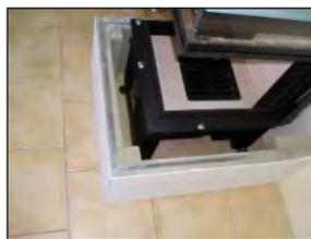
**Punkt 5.** Setzen Sie der Untersims **2** auf dem Sockel. Regulieren Sie Untersims mit Holzkeil beim Boden und Kamineinsatz mit Stellfüßen zum Niveau. Spalt zwischen Untersims und Kamineinsatz soll 2mm haben.
