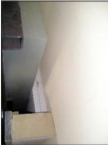
**Punkt 7.** Kleben Sie untere Teil von Isolation bis Wand und festigen Sie alles mit Dübel  $\Phi$  8mm.
