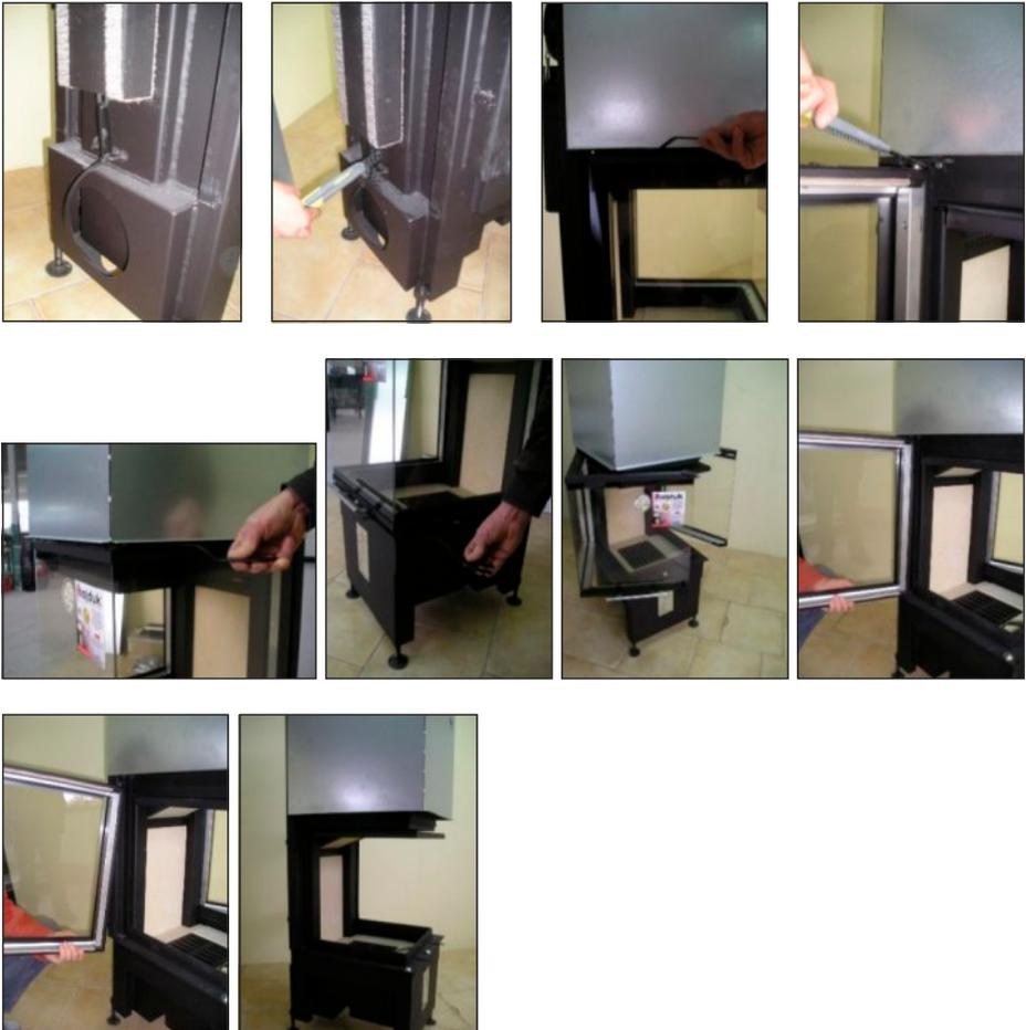
**Punkt 2.** Stellen Sie Kamineinsatz bei der Schornsteinachse und Regulieren Sie die Stellfüße mit ein Schlüssel 24. Der Kamineinsatz muss auf die Höhe von 550 mm Unterkante Zarge Rahmen ausgerichtet werden. Jetzt müssen Sie die Silbersicherungsmutter Schraube lösen.
