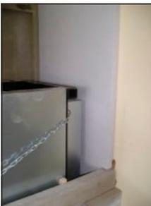
**Punkt 11.** Schließen Sie jetzt den Kamineinsatz mit Schornsteinanschluss an. Alle Verbindungstellen sollen dicht schließend sein. Dichten Sie alles mit Silikon Dichtmasse 1500°C.
