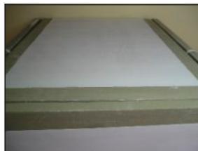
**Punkt 13. und 14.** Nach austrocknen tragen eine dünne Putzschicht und eine Fassadennetz ein. Tragen Sie Eckputzschienen auf und nach dem Putz austrocknen regulieren Sie Putzdicke. Alles soll Glatt geputzt sein. Schneiden Sie Löcher für Gitter.
